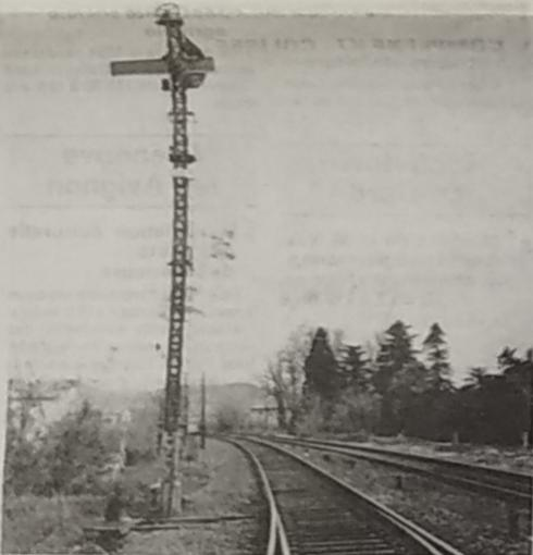
Physionomie traditionnelle des chemins de fer d'antan. Le sémaphore de cantonnement avec fil de fer, contrepoids et commande manuelle (sortie nord de la gare à Capite).
